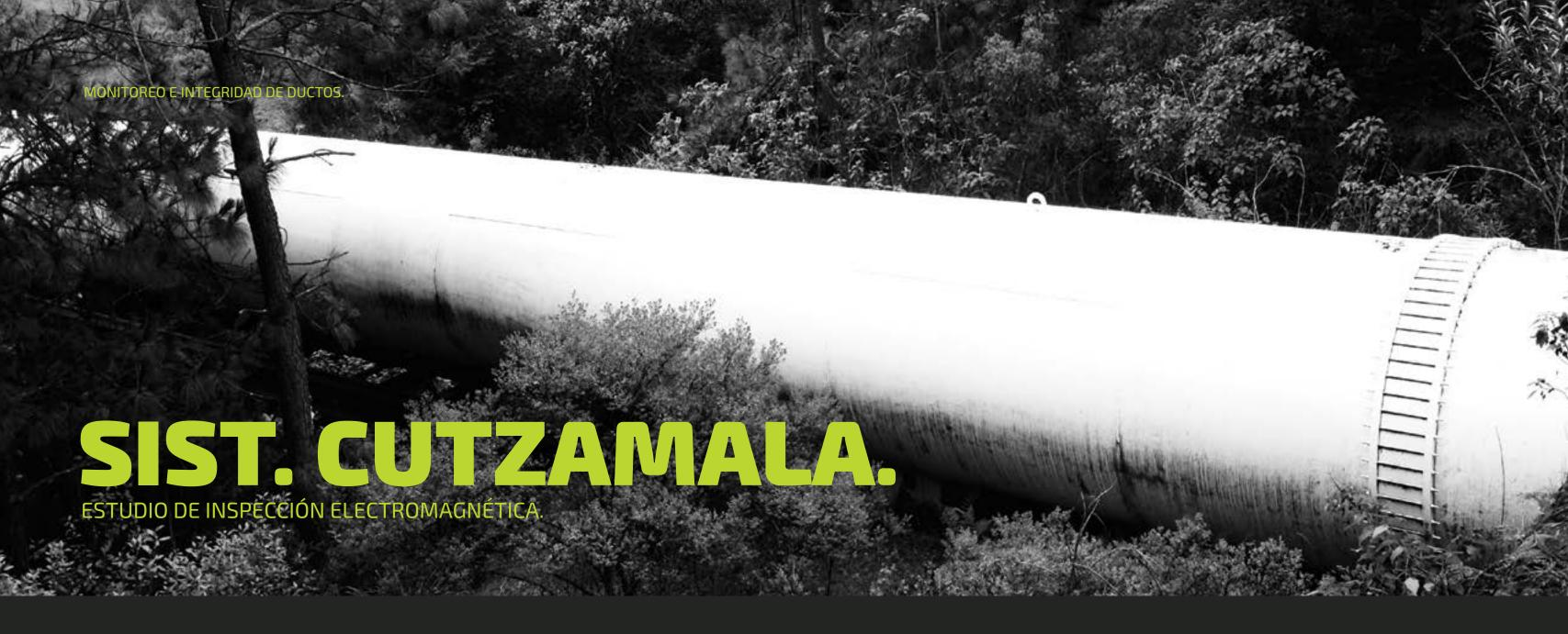
El Sistema Cutzamala se compone aproximadamente de 155.35 km de tubería de concreto pretensado con diámetro predominante de 99" (2,475 mm), actualmente se compone de dos líneas de conducción paralelas. La primera línea denominada línea 1 tiene 30 años de servicio, mientras que la línea 2 y más reciente cuenta con 20 años.
